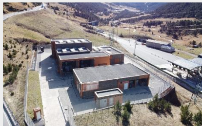
Inici de la construcció del parc solar a Grau Roig
