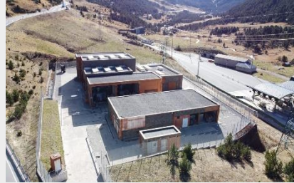
Entrada en funcionament parc solar a Grau Roig
