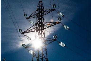
Continuació de la construcció de la línia d'alta tensió d'Encamp a Grau Roig - 2024
